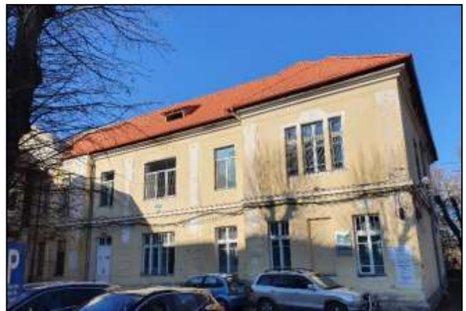
Înlocuirea acoperișului la Spitalul Orășenesc Huedin
