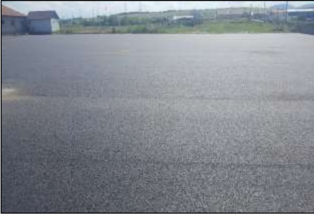
Turnarea stratului de asfalt
