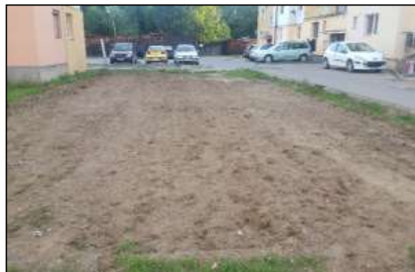
Decopertare parc de joacă - strada Avram
