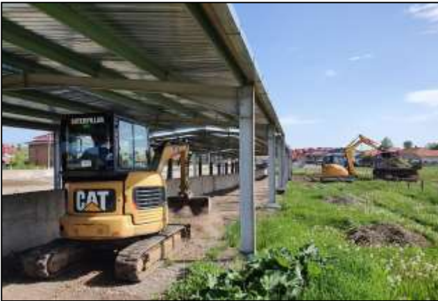
Decopertare și nivelare teren
