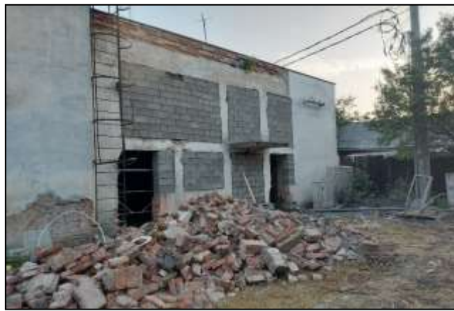
Începerea lucrărilor de amenajare
