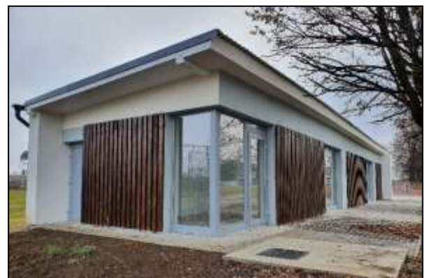
Vestiarele și băile la finalul lucrărilor
