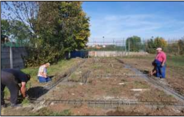
Turnarea fundației și armarea structurii de sprijin
