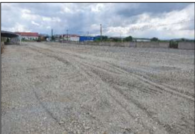
Spațiul reamenajat prin decopertare, pietruire și nivelare
