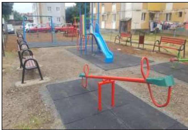
Amenajare parc de joacă - strada Avram Iancu
