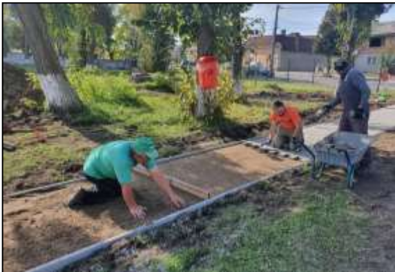
Nivelare nisip și plasare dale
