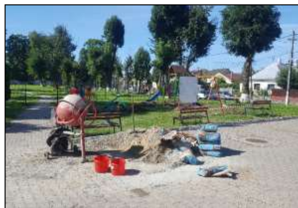
Lucrări de reamenajare a parcului de joacă
