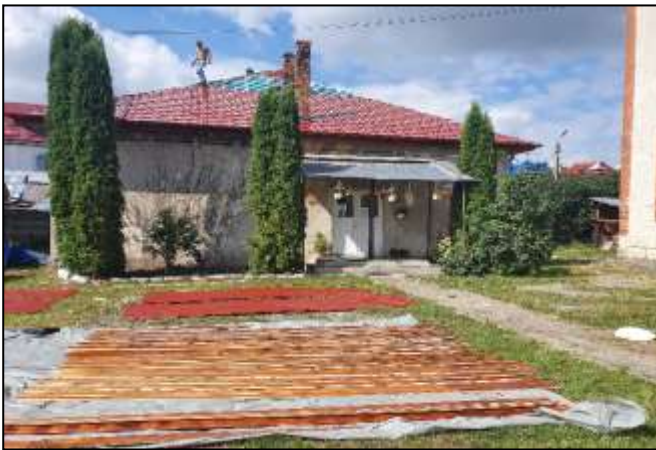
Acoperiș nou la Centrul de Documentare și Informare
